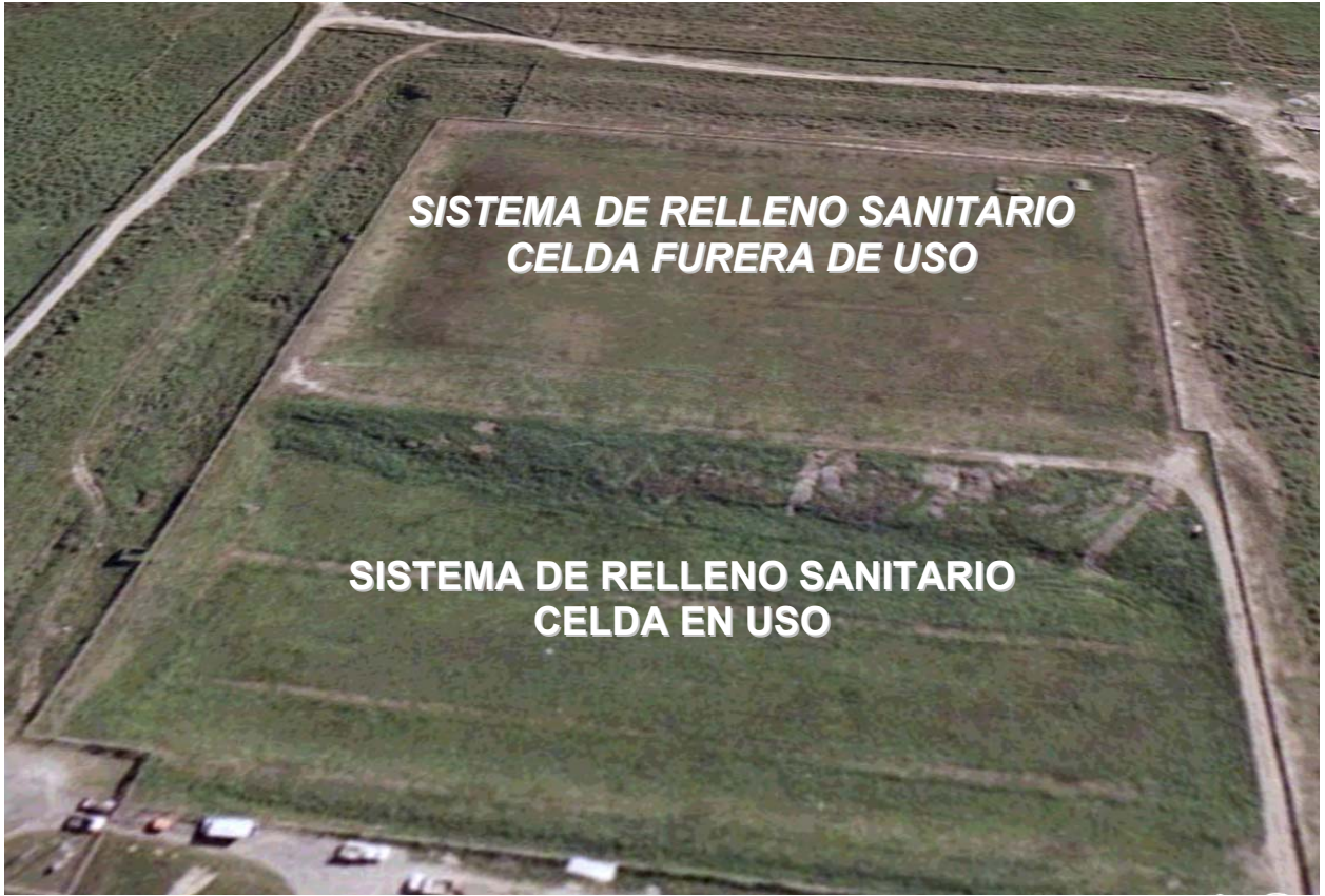
Figura 7. Foto Aérea Sistema de Relleno Sanitario.
