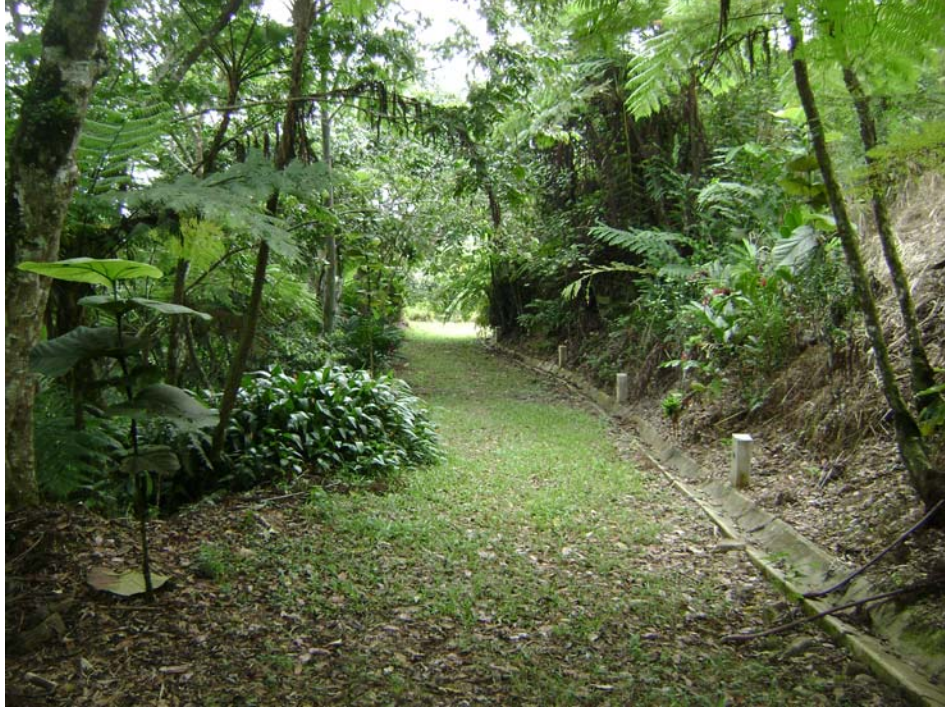
Apéndice 2: Foto en dónde se muestra la vereda principal existente. A la derecha se observa parte de la infraestructura de drenaje construida para el manejo efectivo de las aguas de escorrentía.
