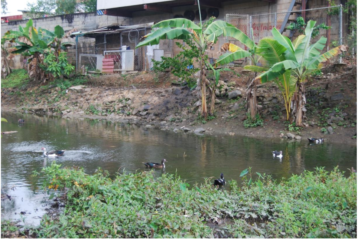
Figura 27. Vista aguas debajo de la mitigación de humedal
