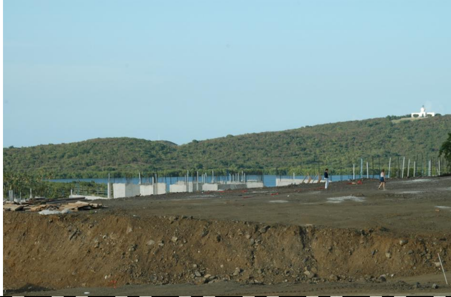
Foto 2 Canalización de quebradas (Coalición Pro Corredor Ecológico del Noreste)
