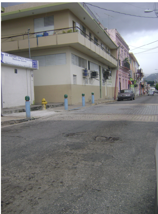
3. Pavimento deteriorado
