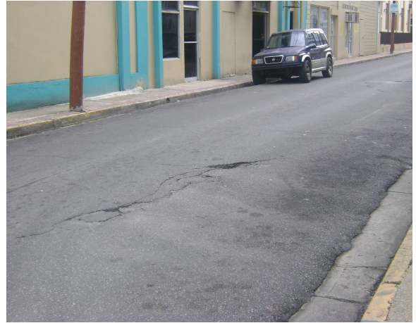
4. Pavimento deteriorado
