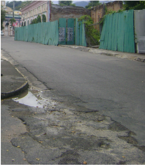
1. Vista de norte a sur
