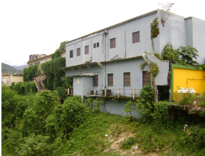
Espaldas de estructuras en calle Dr. Cueto
