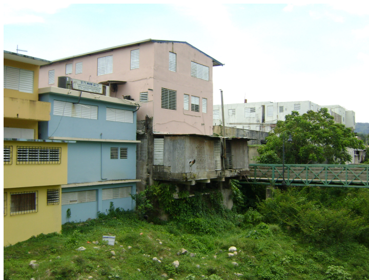
Espaldas de estructuras en calle Dr. Cueto
