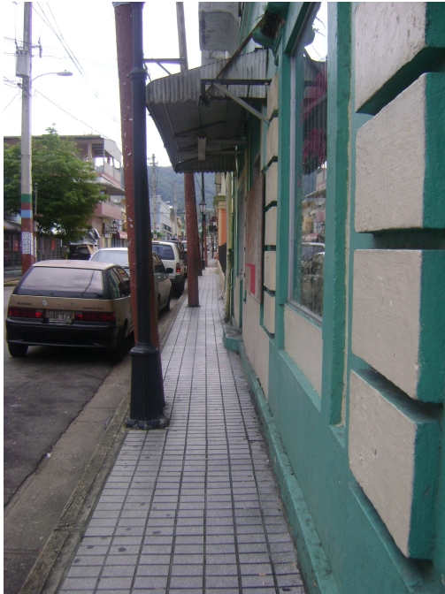
1. Obstrucciones en aceras por postes de alumbrado
