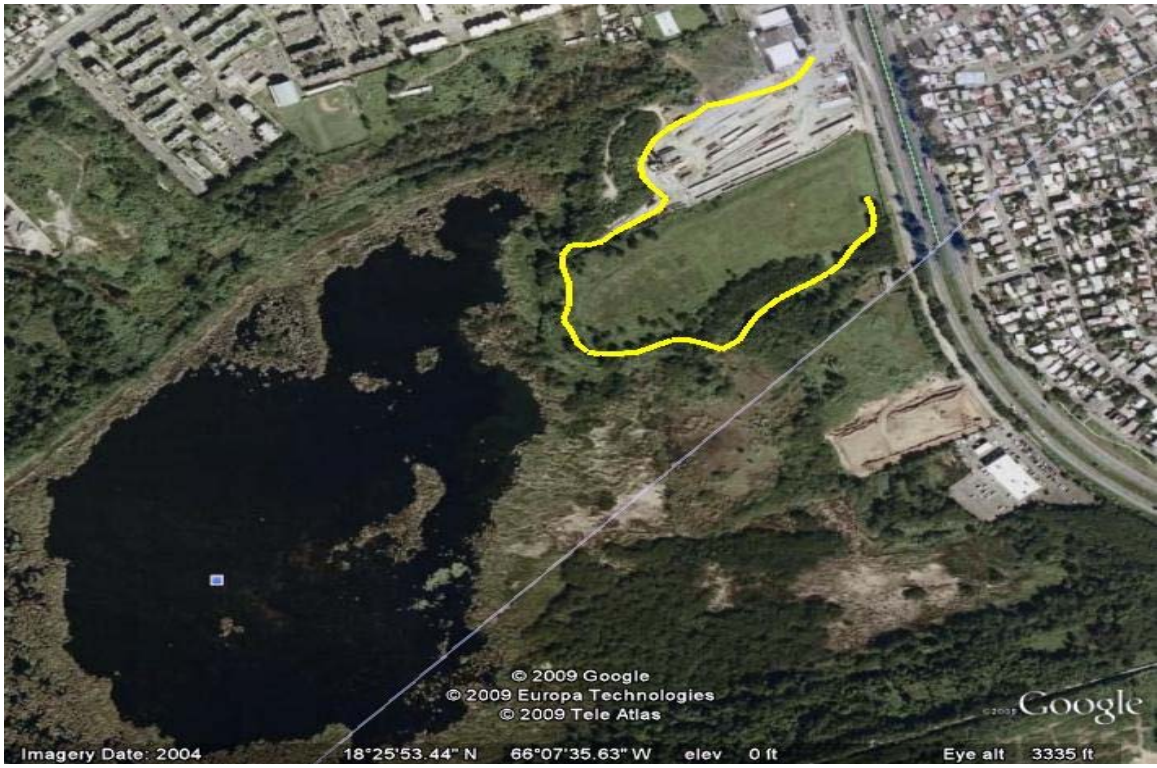
Figura 1. Transepto las Cucharillas.
