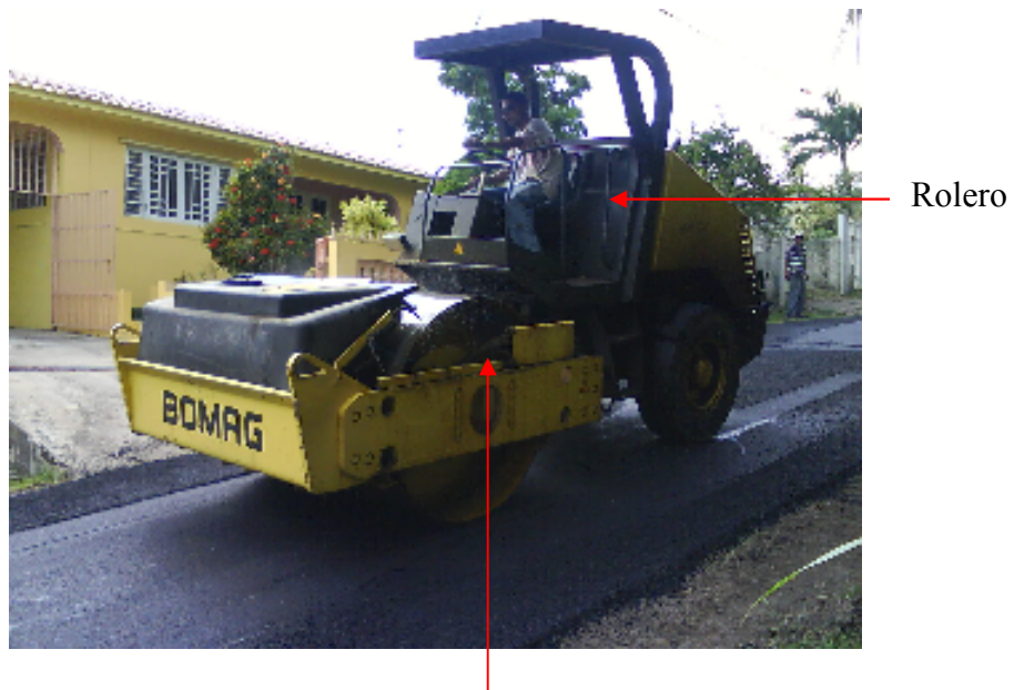
Figura 1: Demostración de diversas tareas de pavimentación realizadas en el sector Palou, en el municipio de Juncos, el 21 de octubre de 2008.
