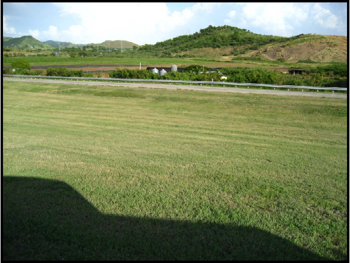
Foto 2: Foto del proyecto de oeste a este.
