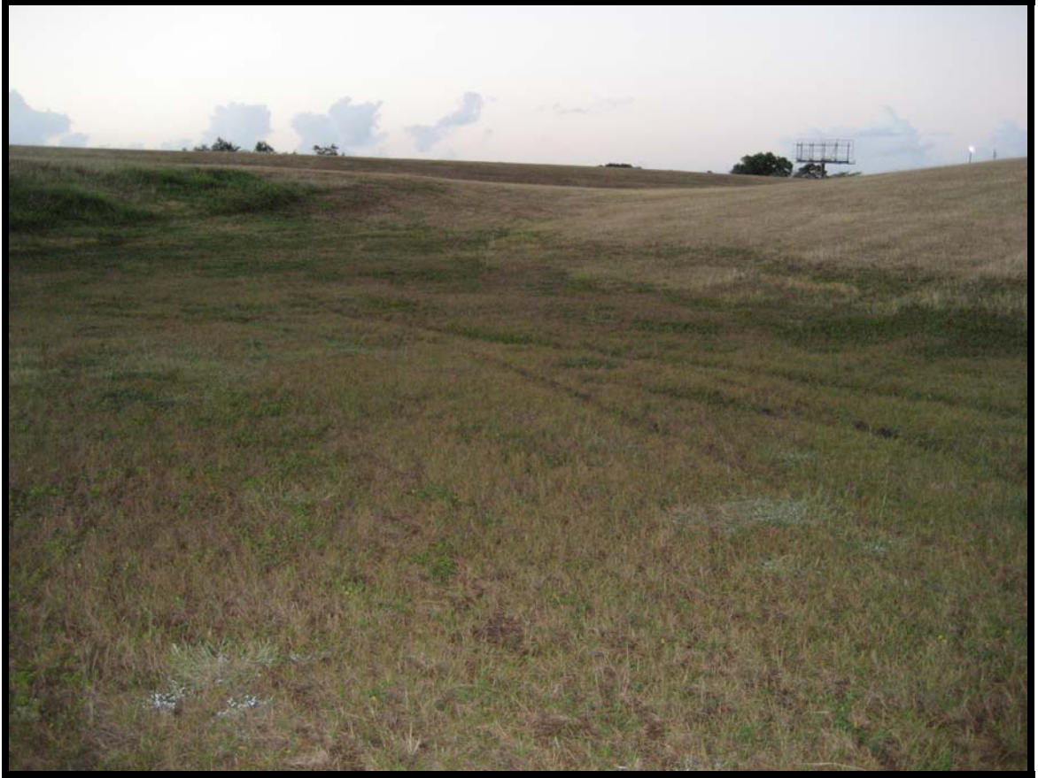
Foto 5: Foto de la sección del proyecto por donde discurren las aguas de escorrentía hasta llegar al sistema pluvial de la autopista.
