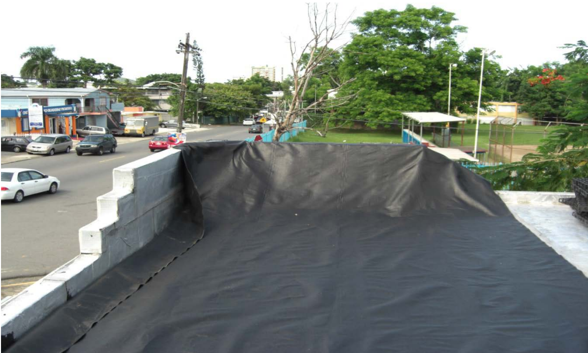
Incorporación de la capa geotextil para proteger la superficie del techo de los daños causados durante la instalación del sistema con cubierta vegetal.
