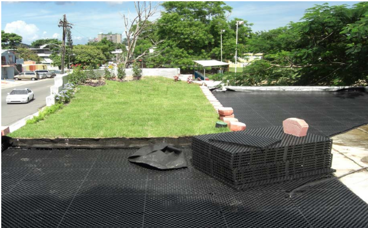
Instalación de la segunda fase del sistema con cubierta vegetal.
