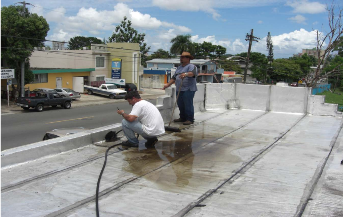
Preparación de la superficie del techo para instalación del sistema.
