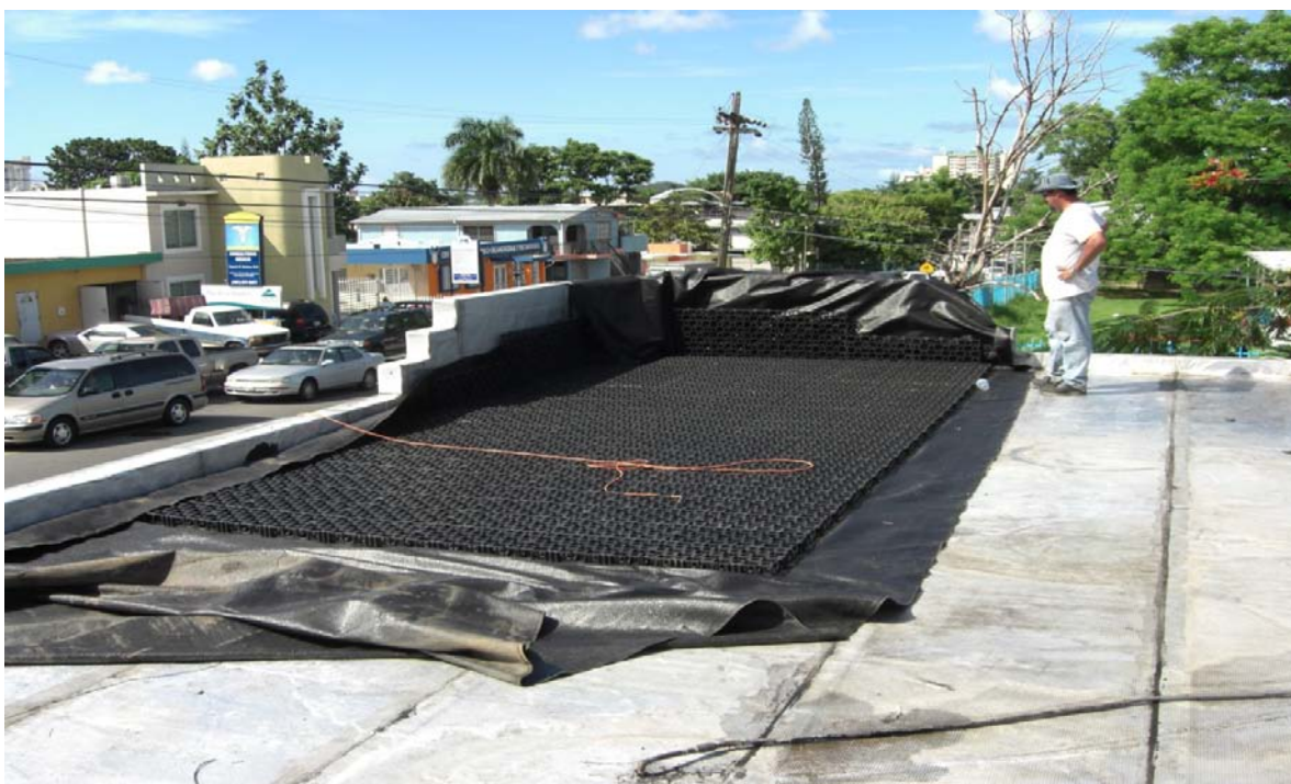
Se instalaron las celdas de drenaje como una cubierta continua sobre la superficie del techo.
