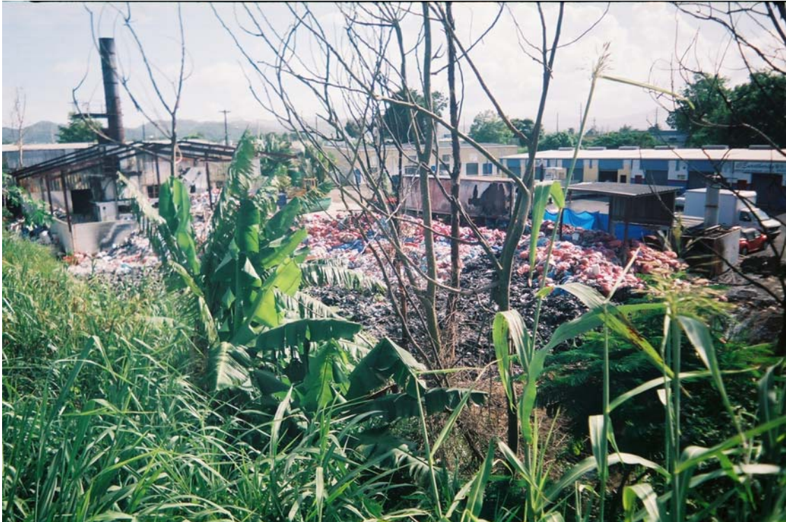
Figura 6. Instalaciones de Biocelsius y antigua estructura que cobijó el incinerador de DBR, vistos desde otra perspectiva. Nótese la chimenea del incinerador al fondo y a la izquierda dentro de la estructura, y sobretodo la extensión del suelo sobre la que estuvieron depositados los DBR. Foto tomada el día 29 de septiembre de 2007.
