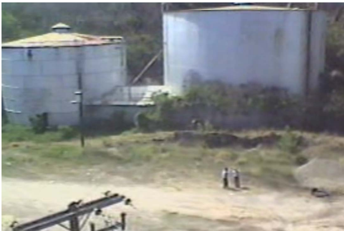
Foto 1: Tanque donde se encontraba el aceite usado.
