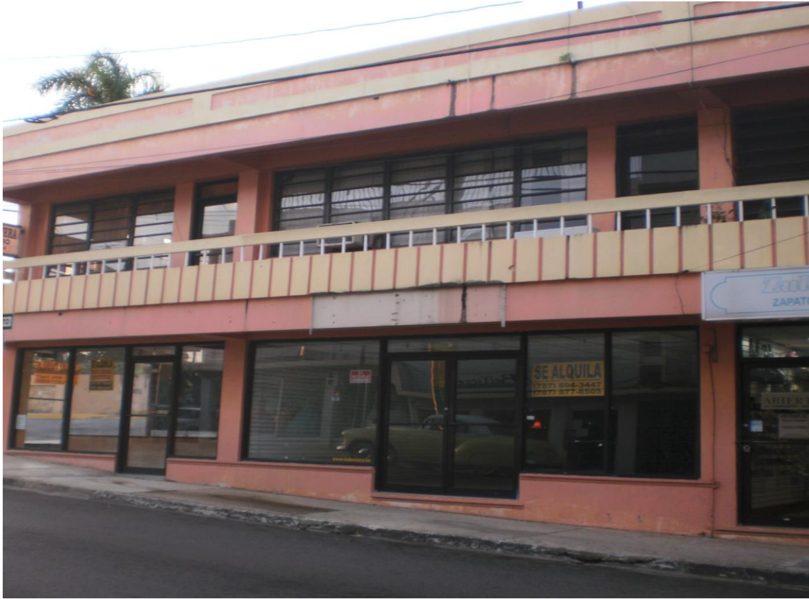
Figura 10. Estructura de uso mixto desocupada, para ser demolida y revitalizar el área.
