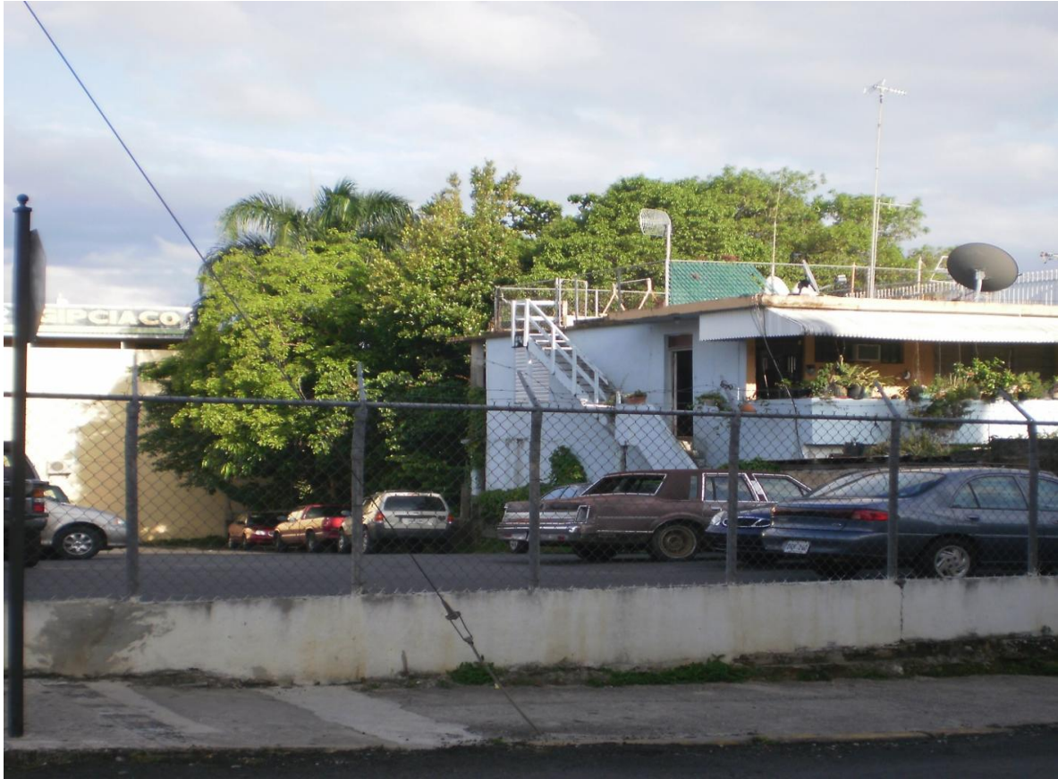
Figura 5. Predio para desarrollar estacionamiento multipisos, en el área donde se ubica la residencia. El mismo contará con un total de 75 a 90 espacios.
