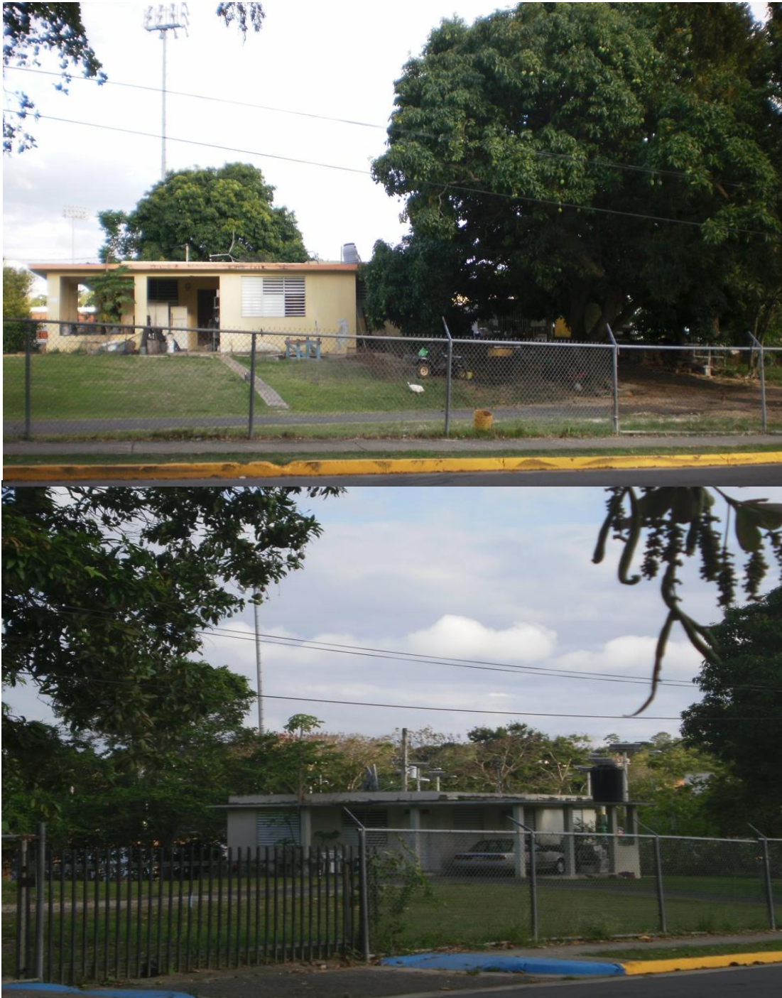
Figura 8. Residencias ubicadas en terreno de 2,500m 2 , las cuales deberán ser expropiadas y desarrollar un área recreacional para el uso de la población que acude a este lugar a ejercitarse, aprovechando las facilidades deportivas que se encuentran en el mismo bloque.
