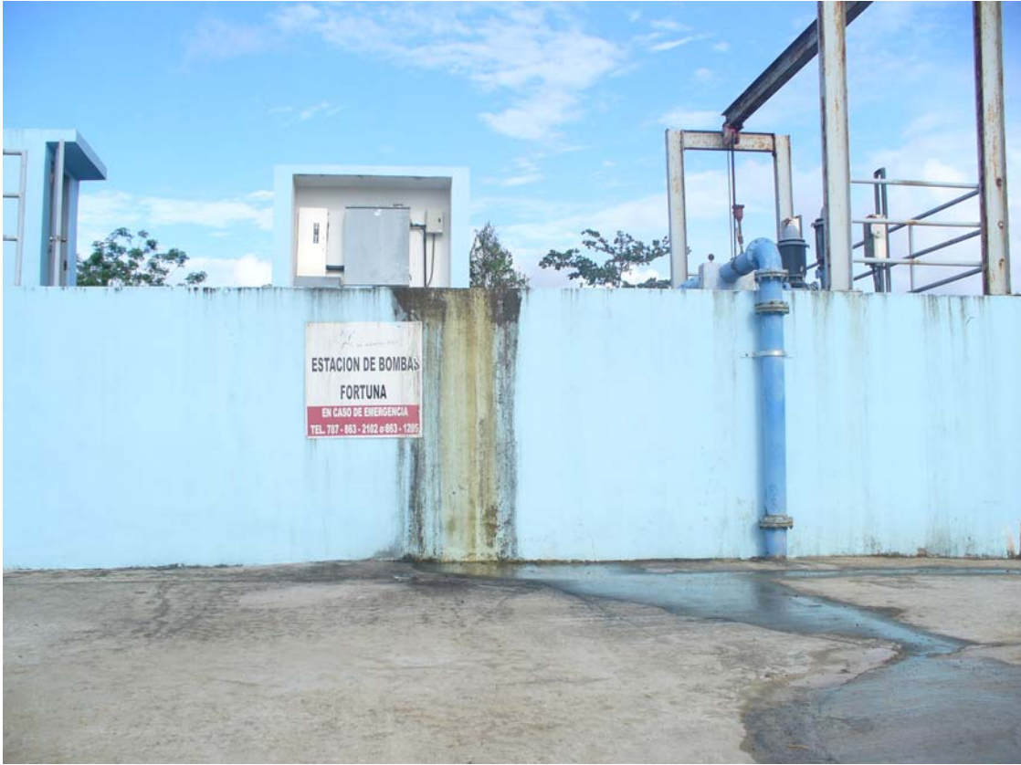
Apéndice 6. Estación de Bombas Fortuna.
