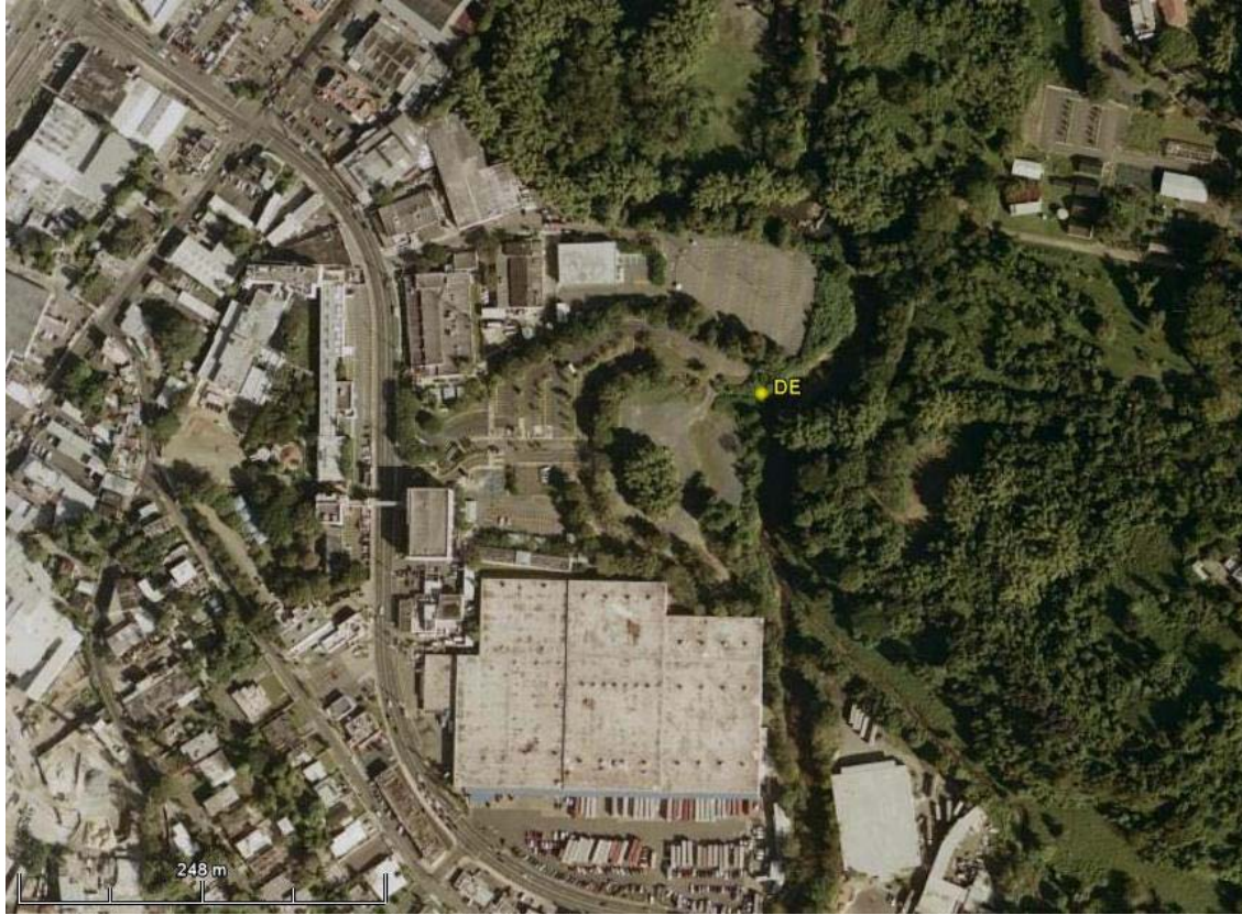
Figura 4. Estación del Canal de Desagüe del estacionamiento UMET.
