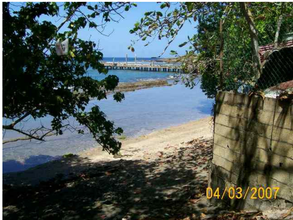
Apéndice 8. Muro de concreto en área de playa de Barceloneta
