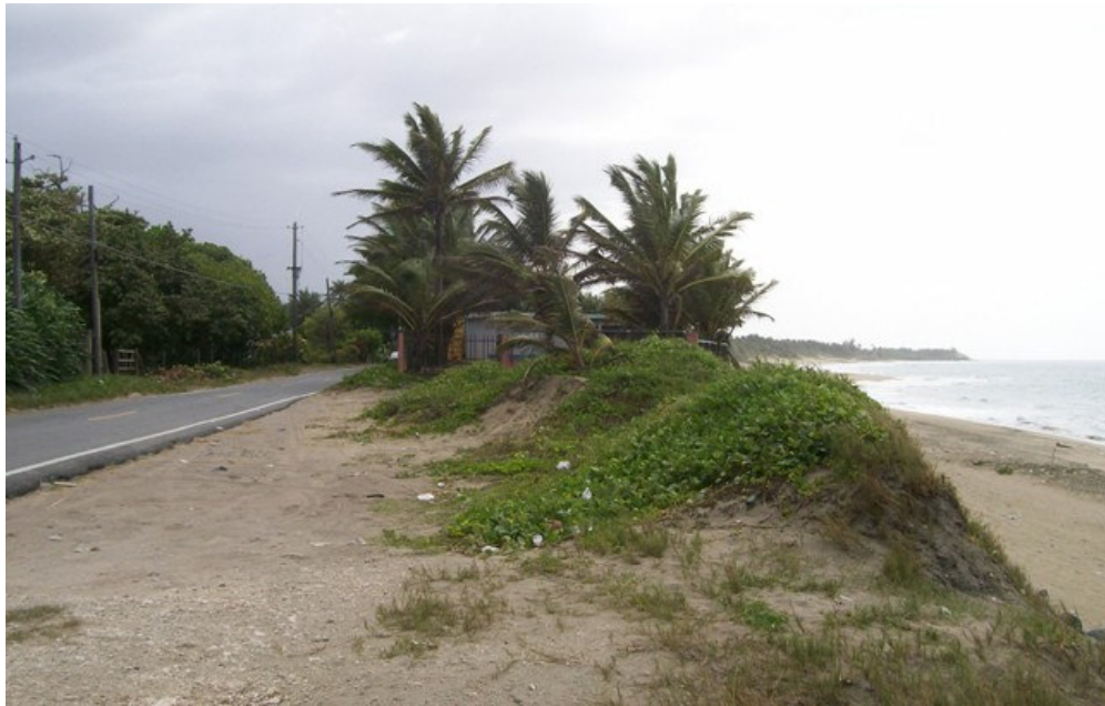
Apéndice 1. Duna que protege la carretera (PR-681)
