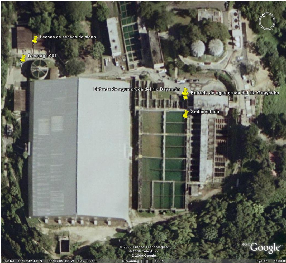
Figura 10. Identificación de los Puntos de muestreo en la Planta de Agua Potable de Guaynabo
