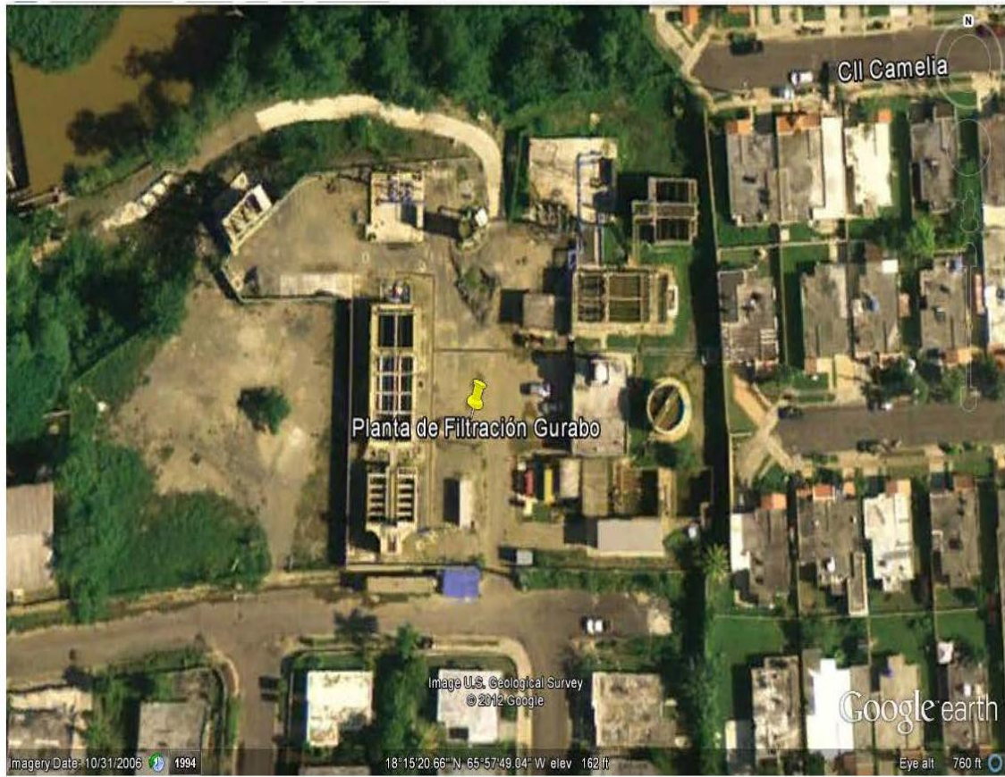
Figura 6. Planta de Filtración de Gurabo
