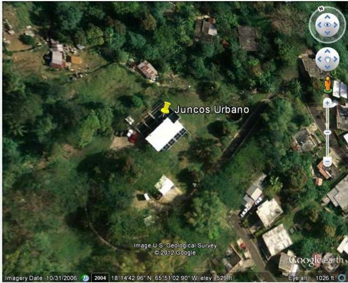
Figura 5. Planta de Filtración Juncos Urbano
