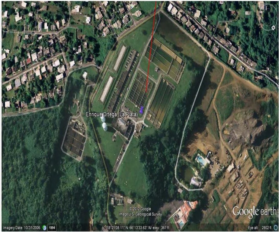
Figura 1. Planta de Filtración Enrique Ortega
