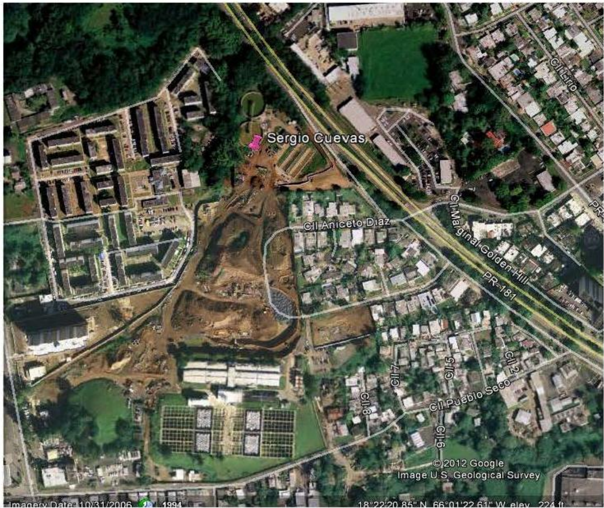
Figura 2. Planta de Filtración Sergio Cuevas
