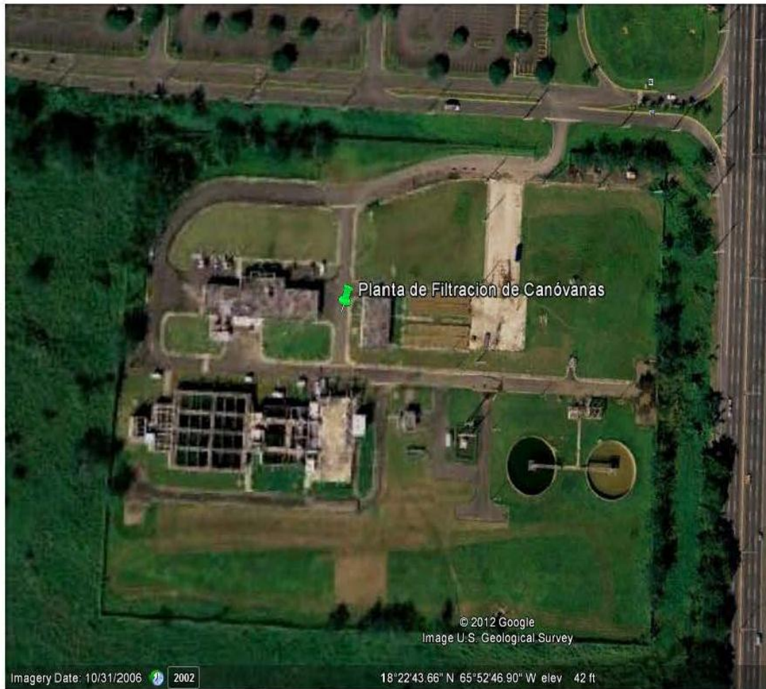
Figura 3. Planta de Filtración Canóvanas
