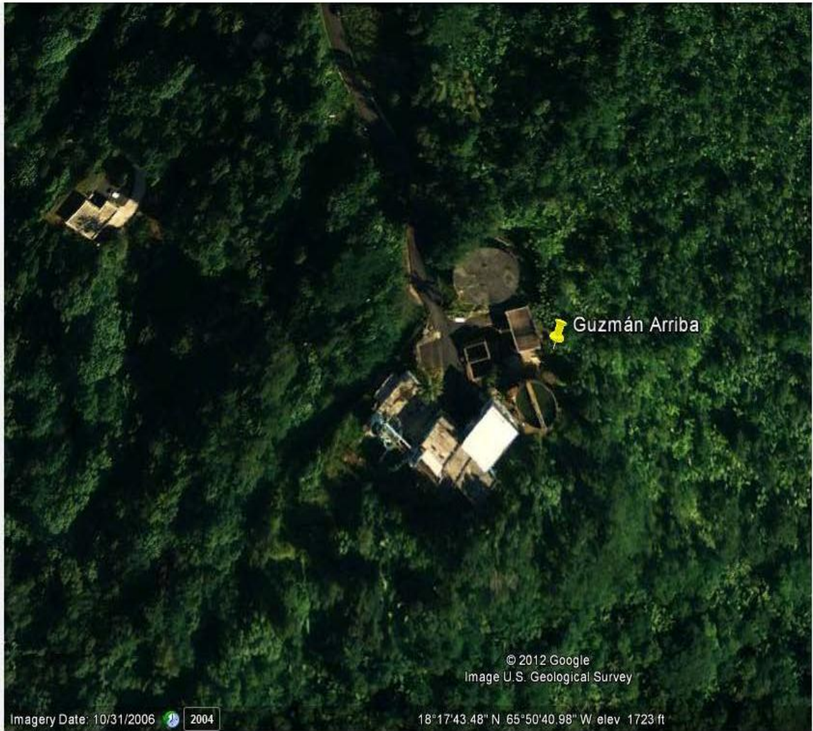
Figura 4. Planta de Filtración de Guzmán Arriba
