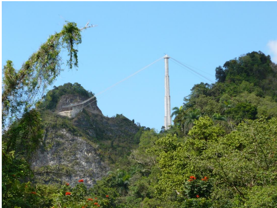
Figura 14. Vista del Observatorio de Arecibo desde el predio P-4.
