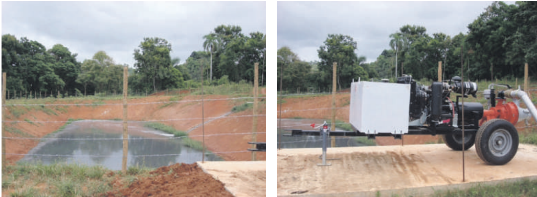
Figuras 3 y 4. Charca de recolección de aguas residuales, y máquina de bombeo para riego en pastos y reutilización del agua.
