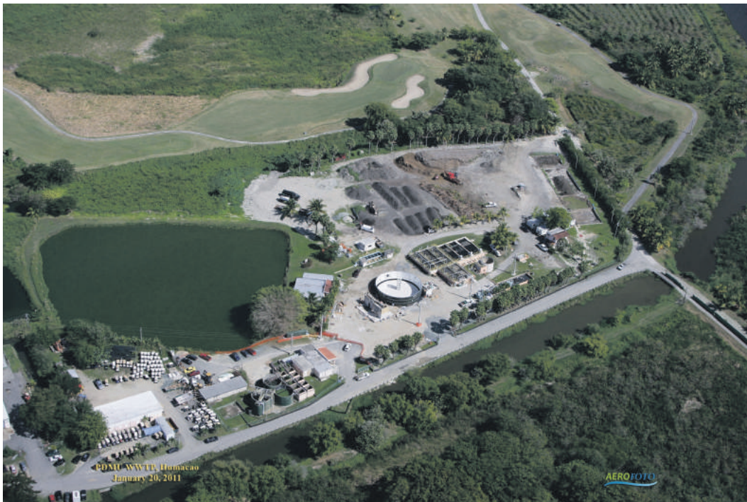
Figura 1. Planta de tratamiento secundario ubicada en Palmas de Mar, Humacao, Puerto Rico.
